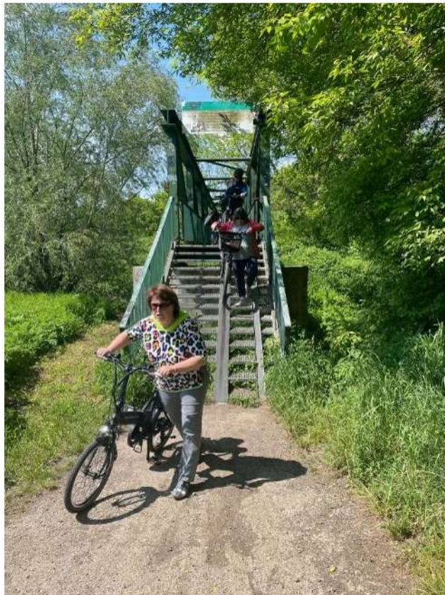
Abbildung 27 Wiesenbrücke über die Pleiße
